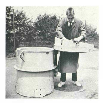
Bild 6 — Abschirmbehälter mit geöffneten Deckel
