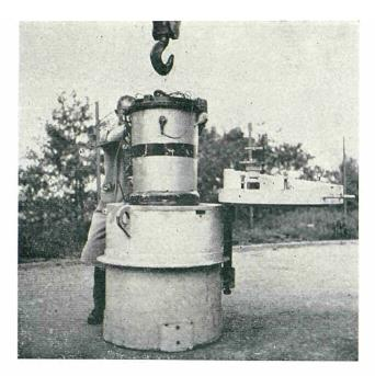
Bild 10 — Einsetzen des Sandgefäßes in den Abschirmbehälter
