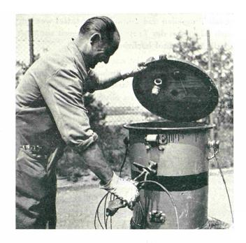
Biid 3 — Sandgefäß mit geöffnetem Deckel. Der Deckelverschluß wird eingesetzt
