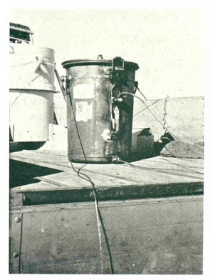
Bild 16 — Probe-Sandgefäß mit gewöhnlichem Sand gefüllt, linkes und rechtes Tragseil sowie Kippseil (mit Zugseil) ausgelegt. Geschlossener und mit Drahtseilen auf dem LKW verspannter Abschirmbehälter
