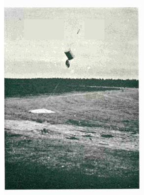
Bild 14 — Das entleerte Sandgefäß hängt am Kippseil. Zugseil mit Deckelverschlußvorrichtung oberhalb des Sandgefäßes sichtbar. Links unten ausgeschütteter Sand (heller Fleck)
