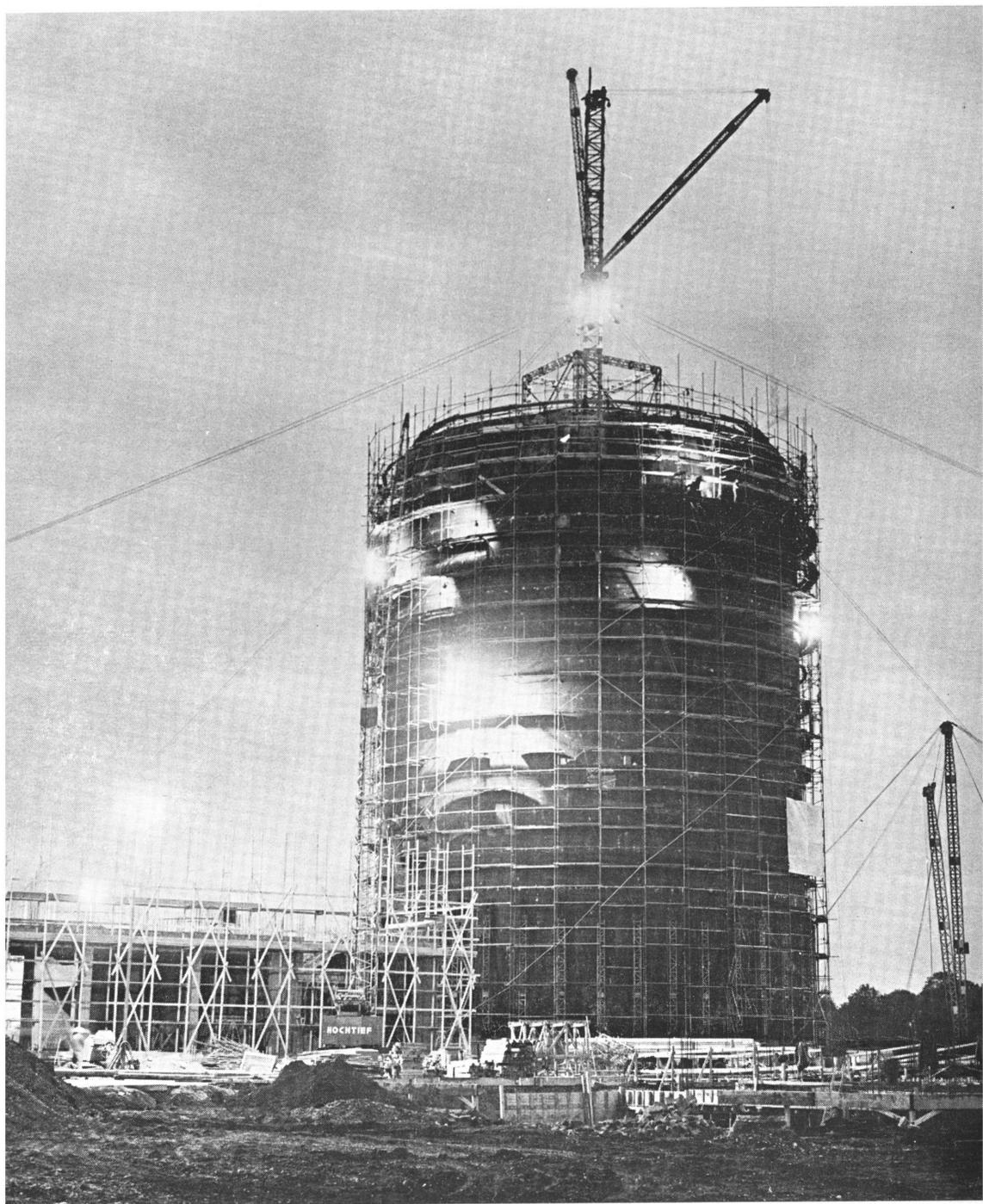
*Vue générale du réacteur de 237 MWe de la Kernkraftwerk Rheinisch-Westfälisches Elektrizitätswerk-Bayernwerk (KRB) actuellement en construction et dont la mise en service est prévue pour 1966.*
