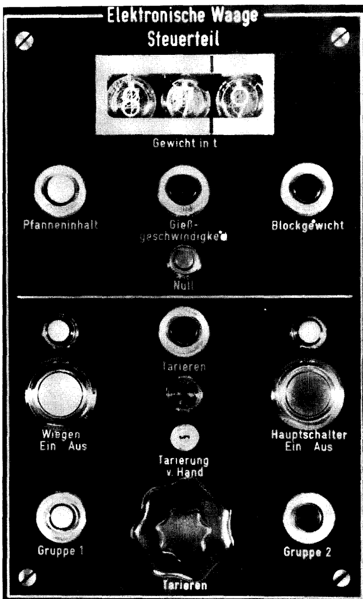
Figure 146 : Pupitre de manœuvre d'une bascule électronique de pont dans la cabine du pontier.
