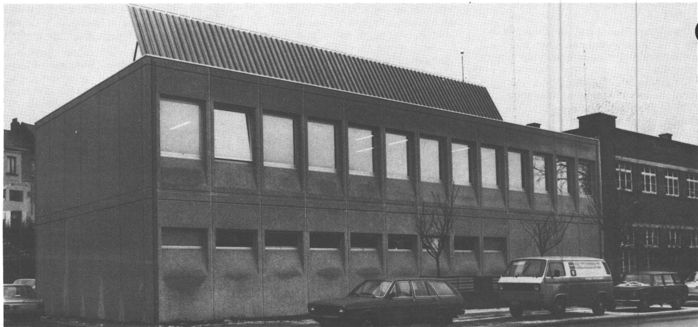
Le Centre d'Hoeilaart, projet présenté par la S.A. Unerg, comporte un système de chauffage et de préparation d'eau chaude utilisant des capteurs solaires sans vitrage refroidis par pompe à chaleur. Le projet perçoit une aide communautaire de 1,5 millions FB.
