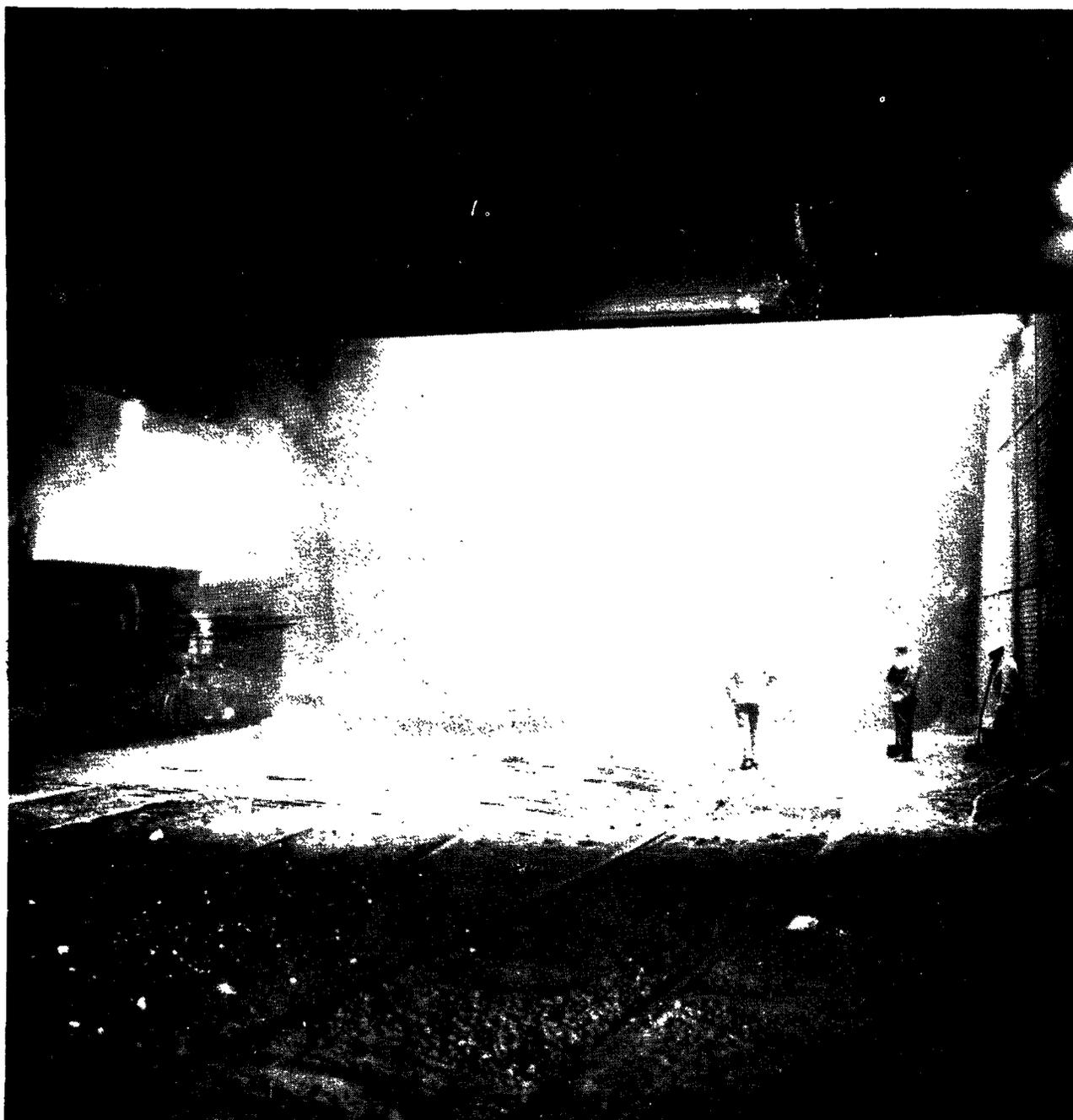
"Photographie de la zone d'interaction prise sous le plancher de HF 1 en direction de HF 3 et de HF 4, tandis que se produit une chute de poussière de HF 1. A droite, trois ouvriers chargés du nettoyage des voies, à gauche cuves à laitier qui viennent d'être remplies. La photographie a été prise en plein jour mais la visibilité est faible, malgré l'allumage de plusieurs lampes, du fait de l'importance de la chute de poussière".
