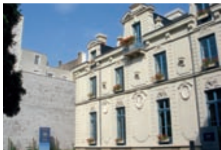
Hôtel Bordeaux-Montrieux, CPVO premises
