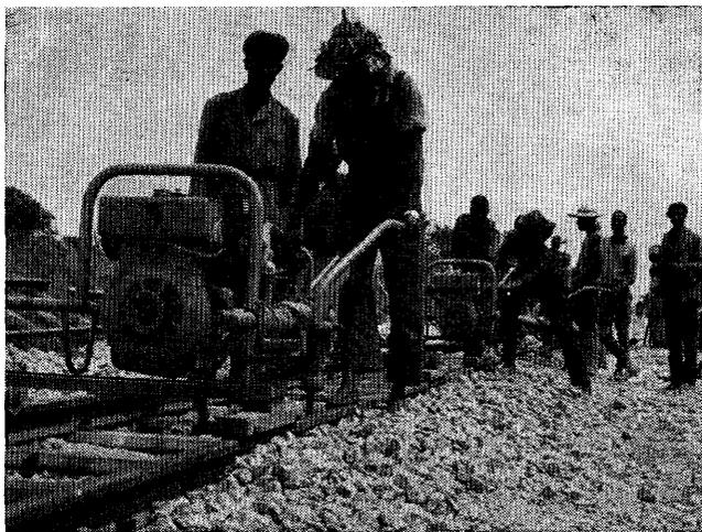
La Régie des Chemins de Fer du Sénégal a demandé au Fonds Européen de Développement (F.E.D.) de participer au financement de la réfection des rails sur la ligne Dakar-Thiès-Tambacunda, ainsi qu'à l'accroissement du matériel roulant. Les rails, posés sur les traverses, sont serrés par un motoserreur dynamométrique. Le montant de cette opération est évalué à 2.900 millions de fr. CFA.
