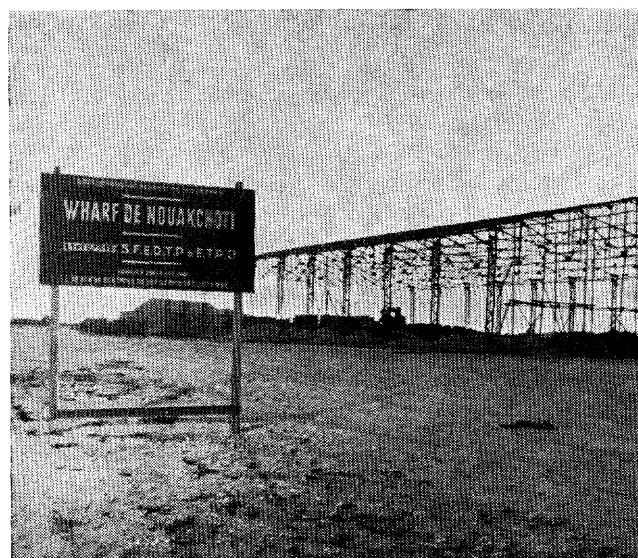
La construction du wharf de Nouakchott (capitale de la Mauritanie) est un des éléments essentiels du développement économique du territoire. Le wharf, avec ses ouvrages annexes, permettra un trafic annuel de 50.000 tonnes, et sera équipé de grues, chaloupes, barges, wagons, etc. Le financement par le Fonds Européen de Développement (FED) de l'ensemble des installations est estimé à 500 millions de fr. CFA. Le wharf de Nouakchott permettra principalement le transport du cuivre, du titane, de la gomme arabique, du gypse et du plâtre. La photo : construction des hangars de stockage.
