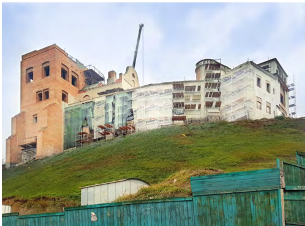
Fot. 15. Odbudowywany zamek w Grodnie, stan z października 2019 r.
