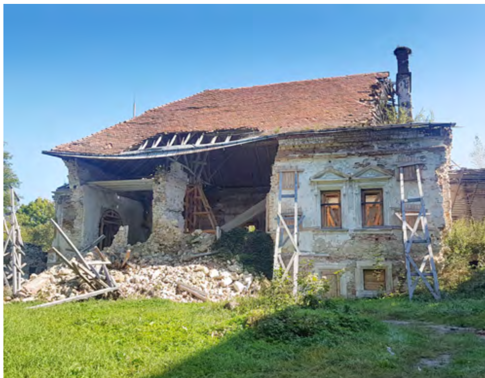
Fot. 3. Zrujnowane skrzydło zamku w Pomorzanach, XVI-XVII w.
